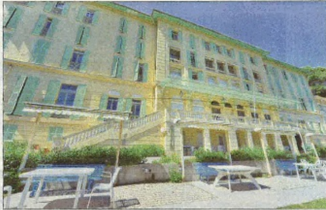
Dans ce bâtiment, une fois rénové, 224 lits d'EHPAD seront disponibles. (Photo: Jean-François Estève)
